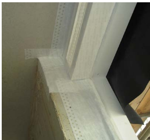
Kozijn aan de binnenzijde luchtdicht afgeplakt.
